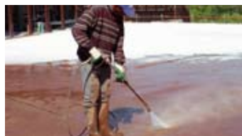
Lavage au surpresseur
